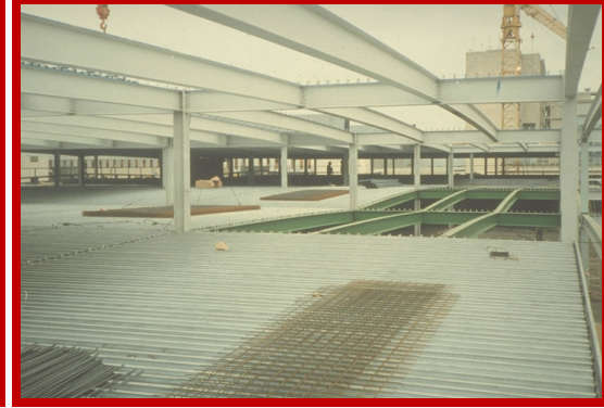
Şekil 9. Ters sehim verilmiş kompozit döşeme kirişleri.
