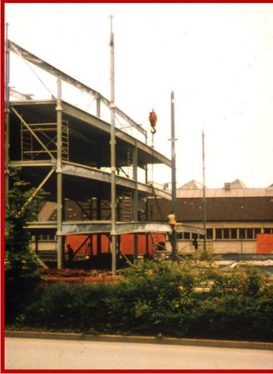
Şekil 9. Ters sehim verilmiş kompozit döşeme kirişleri.
